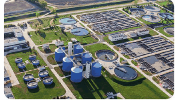
Su arıtma tesisi
